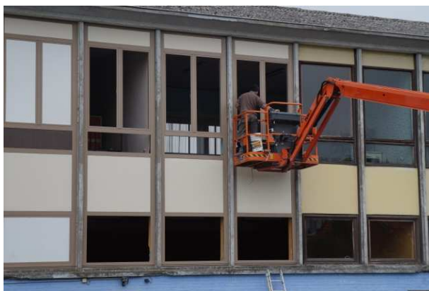
Travaux au Centre pastoral 'Belle-eau'
